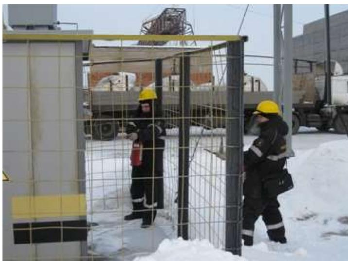
*После отключения линейного разъединителя на опоре ВЛ приступили к тушению возгорания.*
